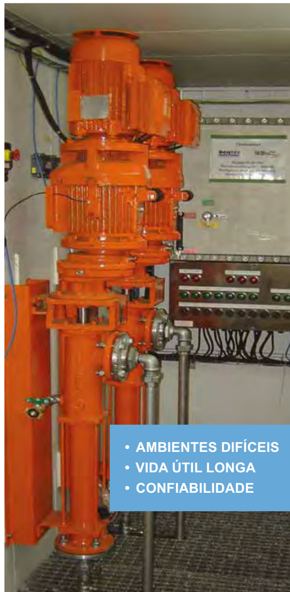
Planta de perfuração de petróleo: variadores de velocidade em bombas de parafuso (Atex ambient)
